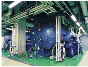
地下に設置されているタービン
